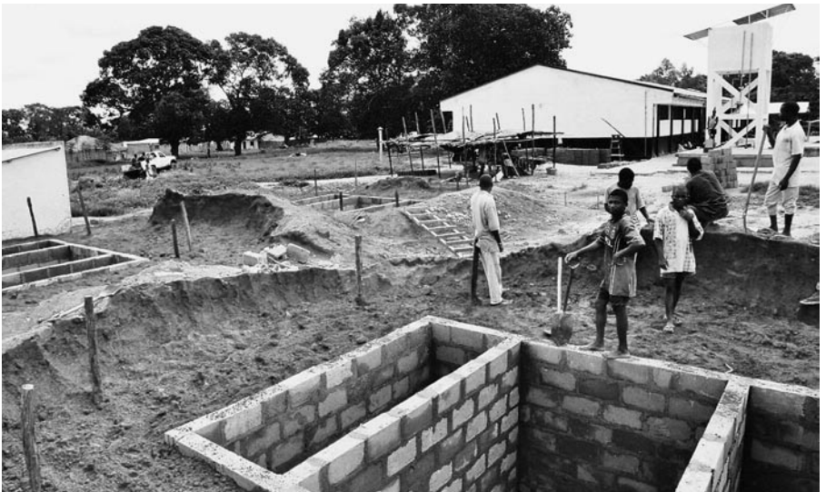
Bauliche Verbesserungen am Gesundheitszentrum in Chiúre, Moçambique.
