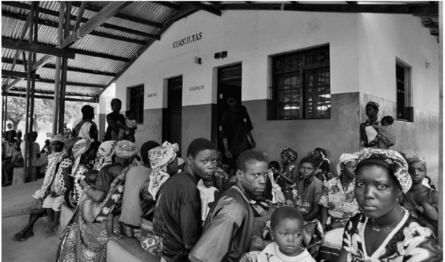
Vor dem Ambulatorium in Chiüre wurde eine überdachte Warte Halle für 200 Patientinnen und Patienten gebaut, welche rege benutzt und sehr geschätzt wird.
