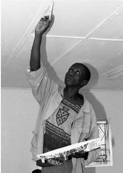
Das Ambulatorium des «Roma Hospital» wird renoviert.
