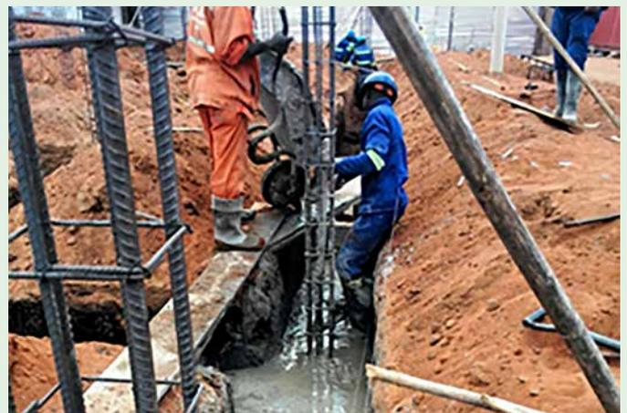
▲ Das Fundament wurde durch lokale Arbeiter von Hand gegossen. Gut sichtbar sind die Eisenstangen und Kabel für die tragenden Säulen. *SolidarMed*
