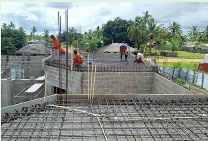
▲ Zum Jahreswechsel wurden die Dachplatte des Operationssaals betoniert und die elektrischen Kabel geschützt. *SolidarMed*
